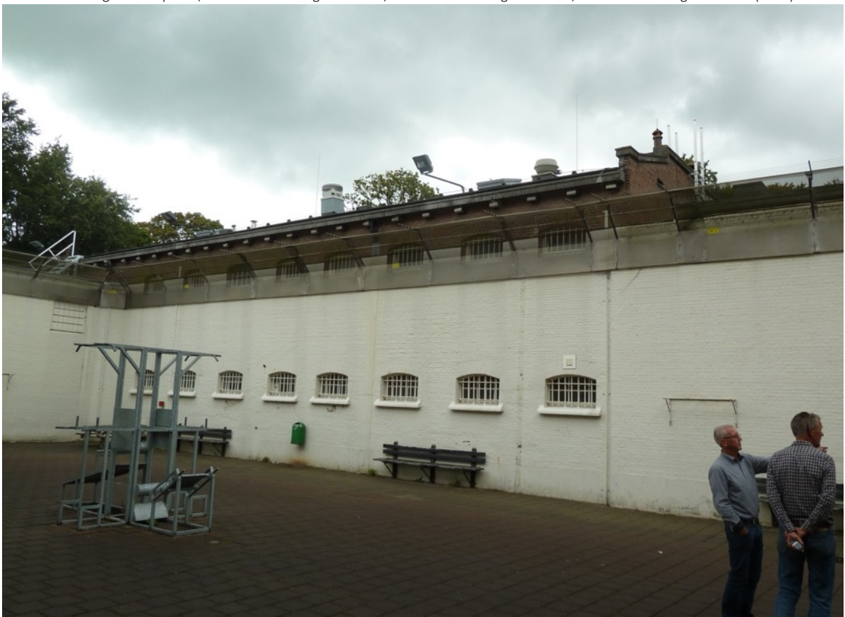
Voormalige binnenplaats, links de inmiddels verwijderde sportvoorziening, rechts dienstenvleugel uit 1891 (2012)
