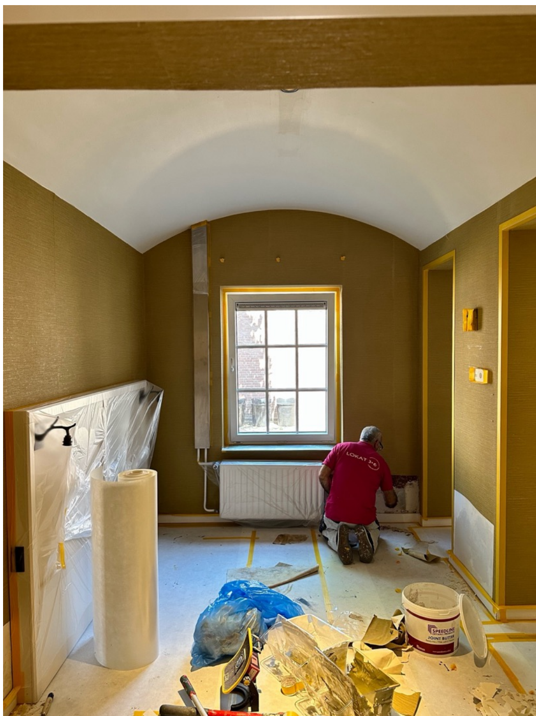
Voormalige (en recent doorgebroken) cel in cellenvleugel uit 1891 wordt verbouwd tot hotelkamer (2023)
