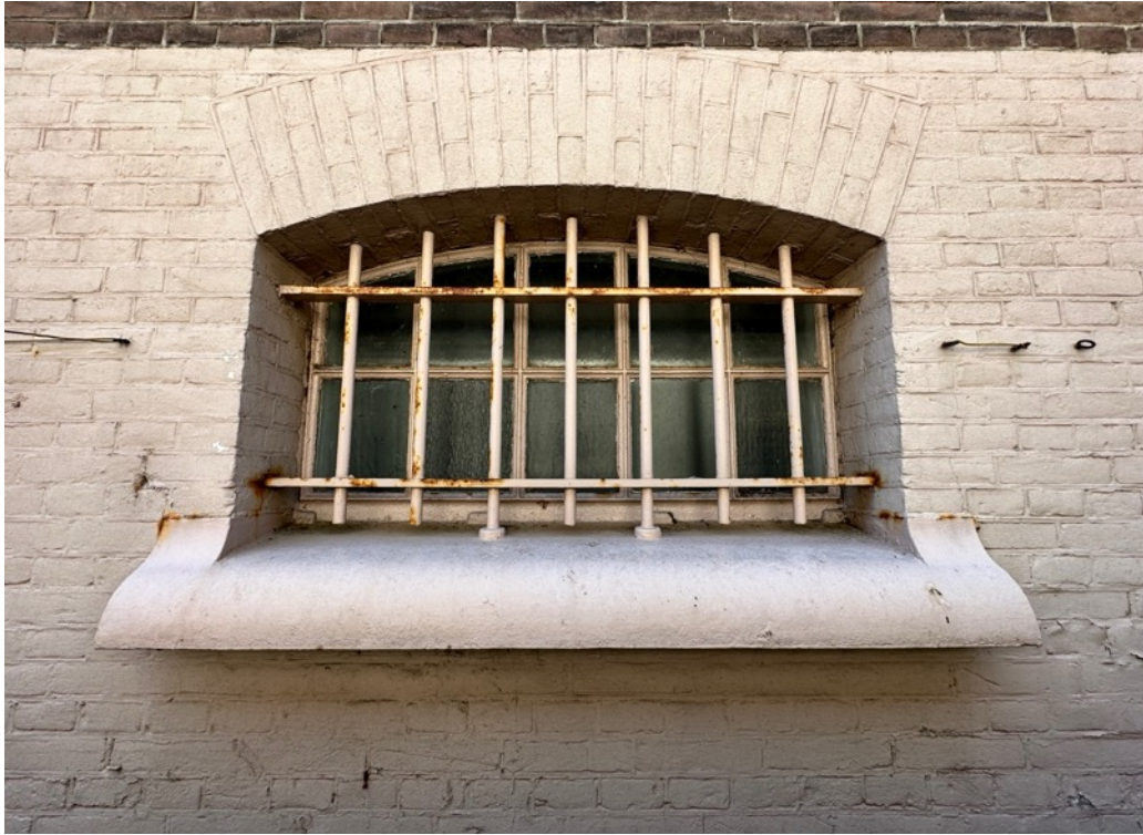
Detail voorgevel dienstenvleugel uit 1891, met onderzijde ventilatievenster en natuurstenen gootklossen (2023)
