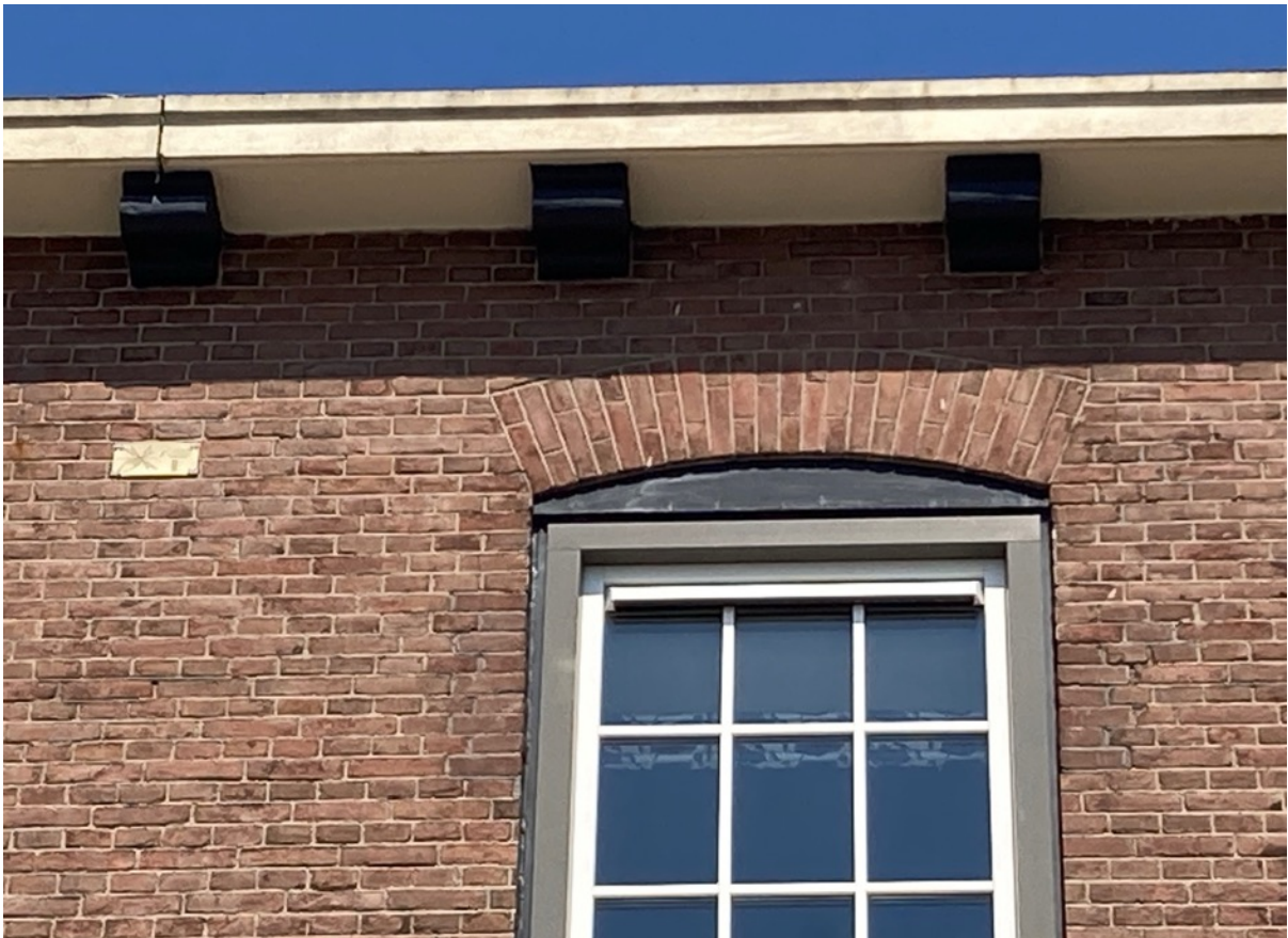
Detail achtergevel cellenvleugel uit 1891, met geschilderde natuurstenen gootklossen en vernieuwd kozijn (2023)
