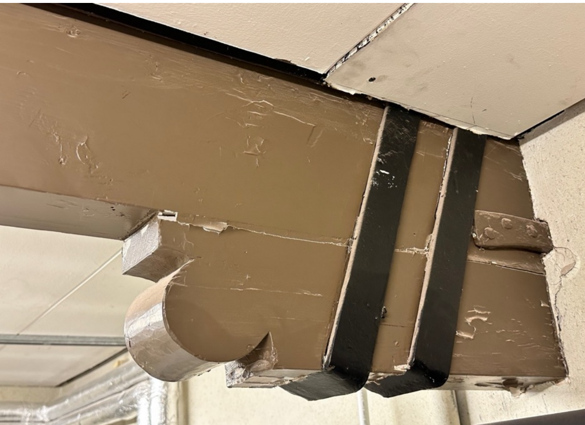
Geprofileerde houten klos van draagconstructie van voorgebouw uit 1884 (2023)
