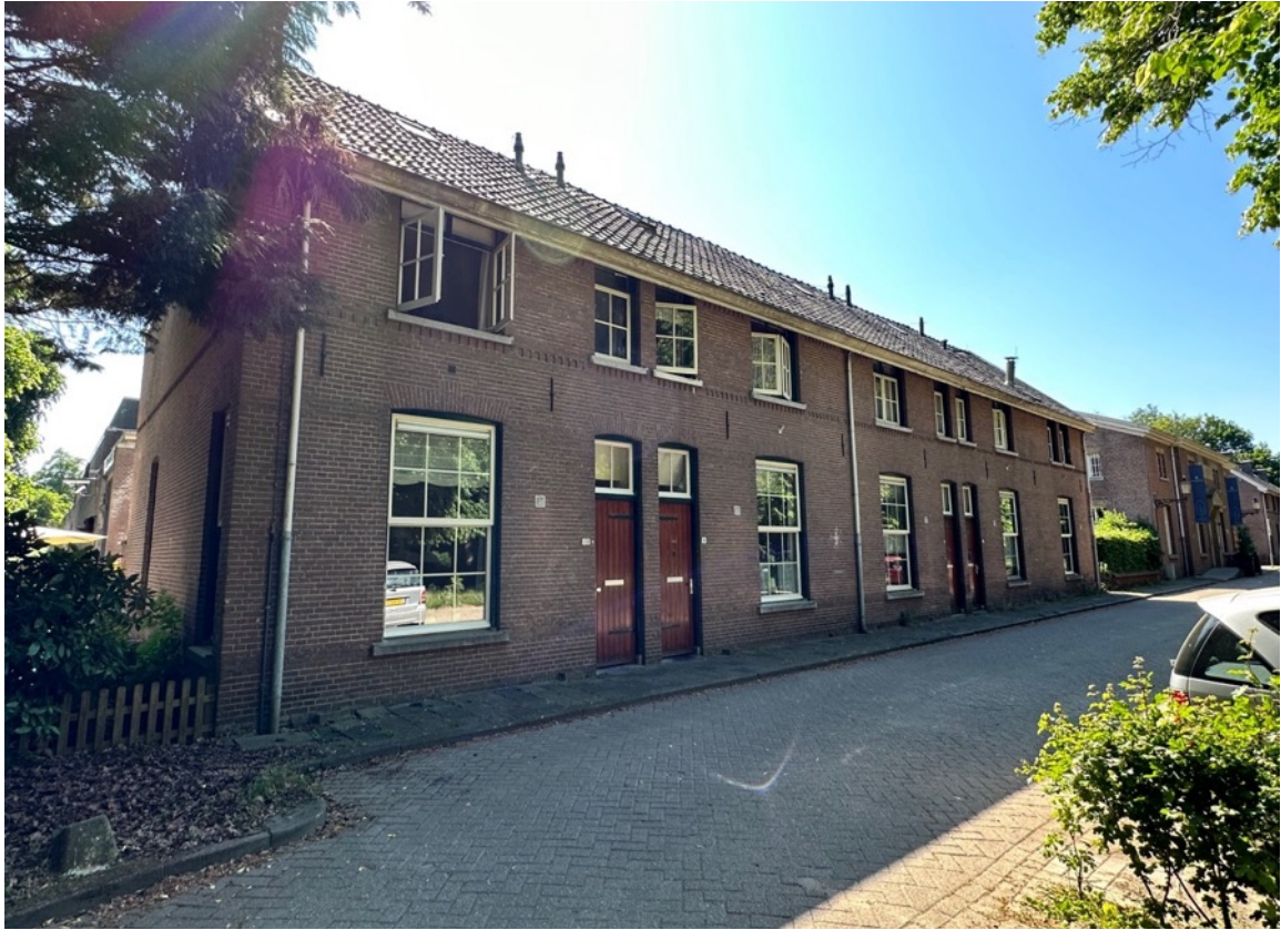
Voorgevel linker dienstwoning-blok uit 1891 (2023)
