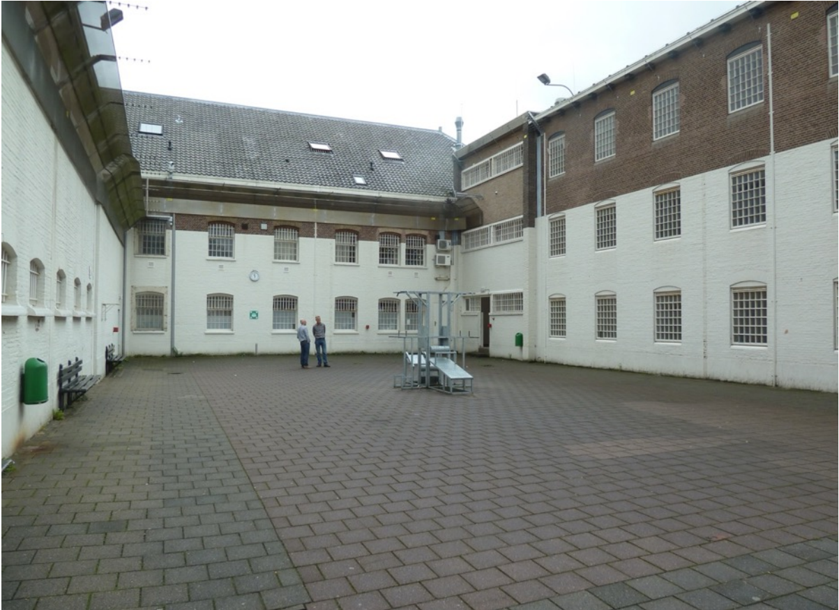
Voormalige binnenplaats, links dienstenvleugel uit 1891, midden cellenvleugel uit 1884, rechts cellenvleugel uit 1891 (2012)
