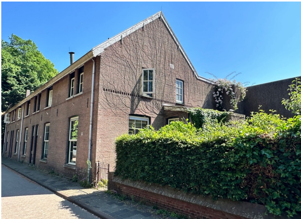
Kop- en voorgevel linker dienstwoning-blok uit 1891 (2023)
