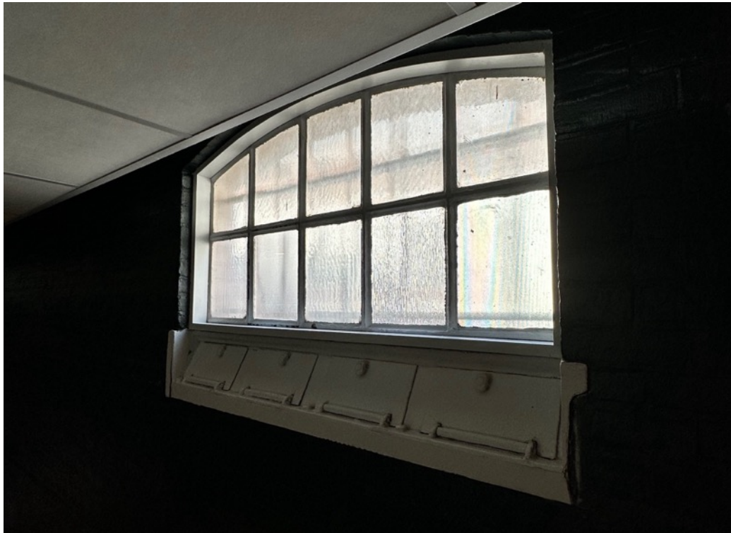
Detail binnenzijde ventilatievensters dienstenvleugel uit 1891 (2023)
