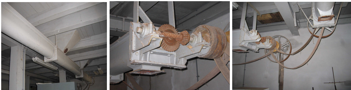
Begane grond: Kolom (beton) links ter hoogte van de kelder: transportvijzel, draaiwielen en poelies.
