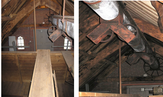
zolder : met koren, rondboogspanten
